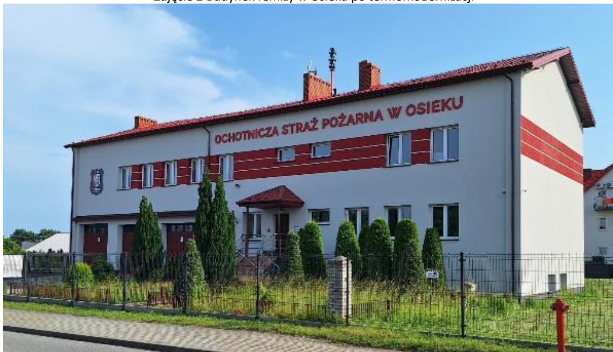
Zdjęcie 2 Budynek remizy w Osieku po termomodernizacji
