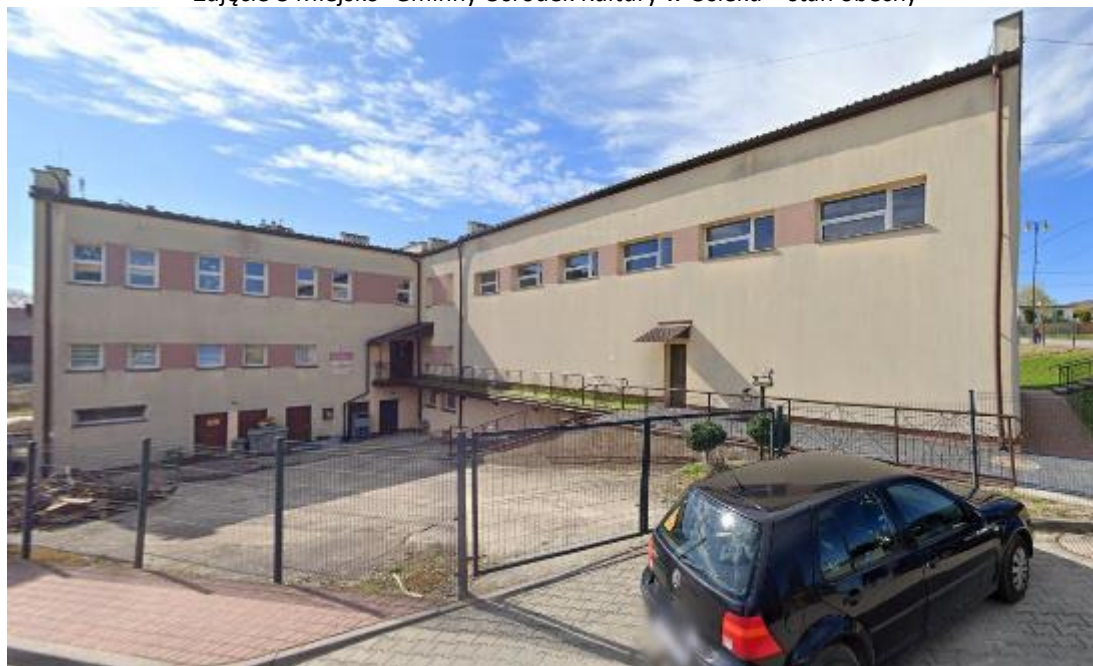
Zdjęcie 8 Miejsko- Gminny Ośrodek Kultury w Osieku – stan obecny
