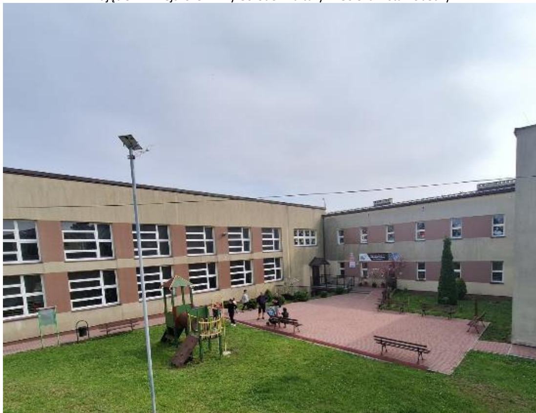
Zdjęcie 14 Miejsko-Gminny Ośrodek Kultury w Osieku – stan obecny
