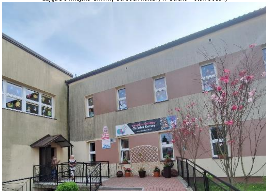
Zdjęcie 6 Miejsko-Gminny Ośrodek Kultury w Osieku – stan obecny
