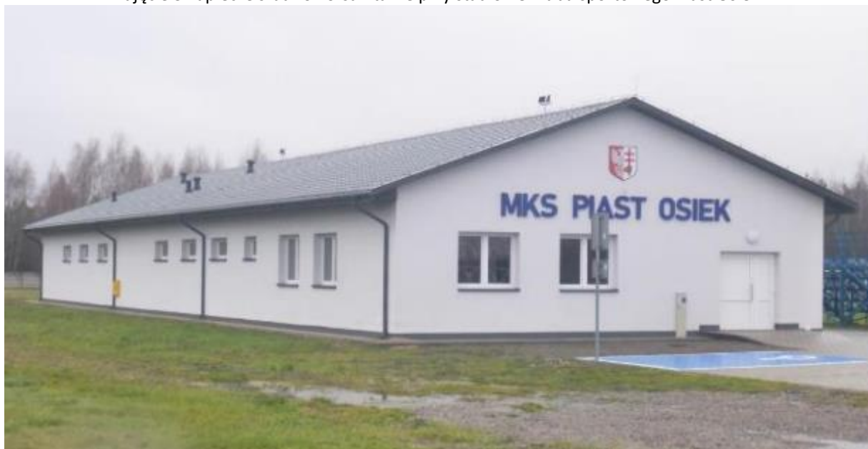
Zdjęcie 3 Zaplecze szatniowo-sanitarne przy stadionie Klubu sportowego Piast Osiek
